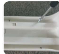
Bevestig de montagebeugel met schroeven
